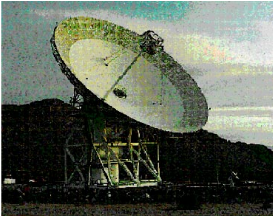
Fig. 1. DSS-13 34-m beam-waveguide antenna.
