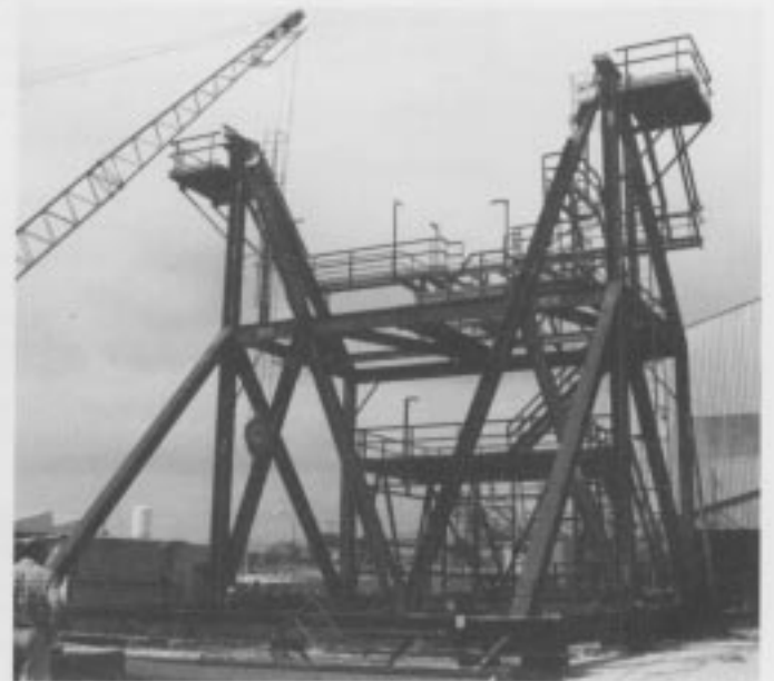
Fig. 4. Allidade structure assembly fit-check, DSS 65
