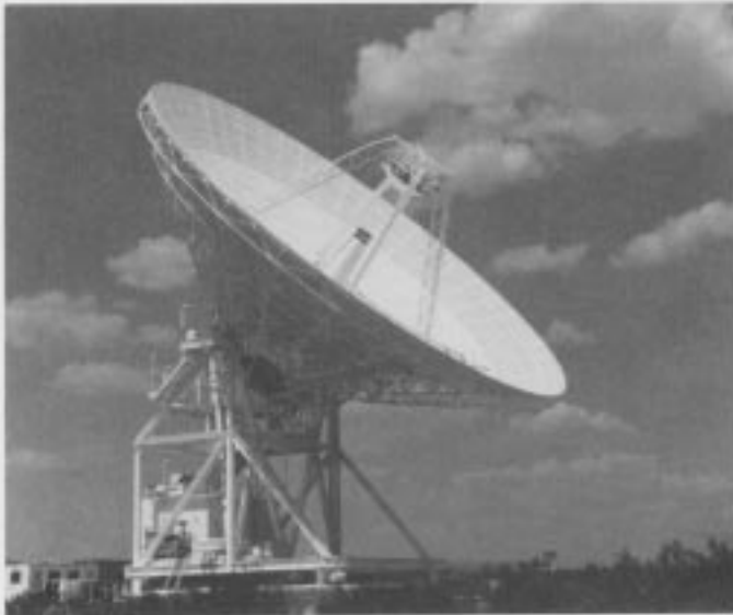
Fig. 1. 34-m Az—EI antenna, DSS 15
